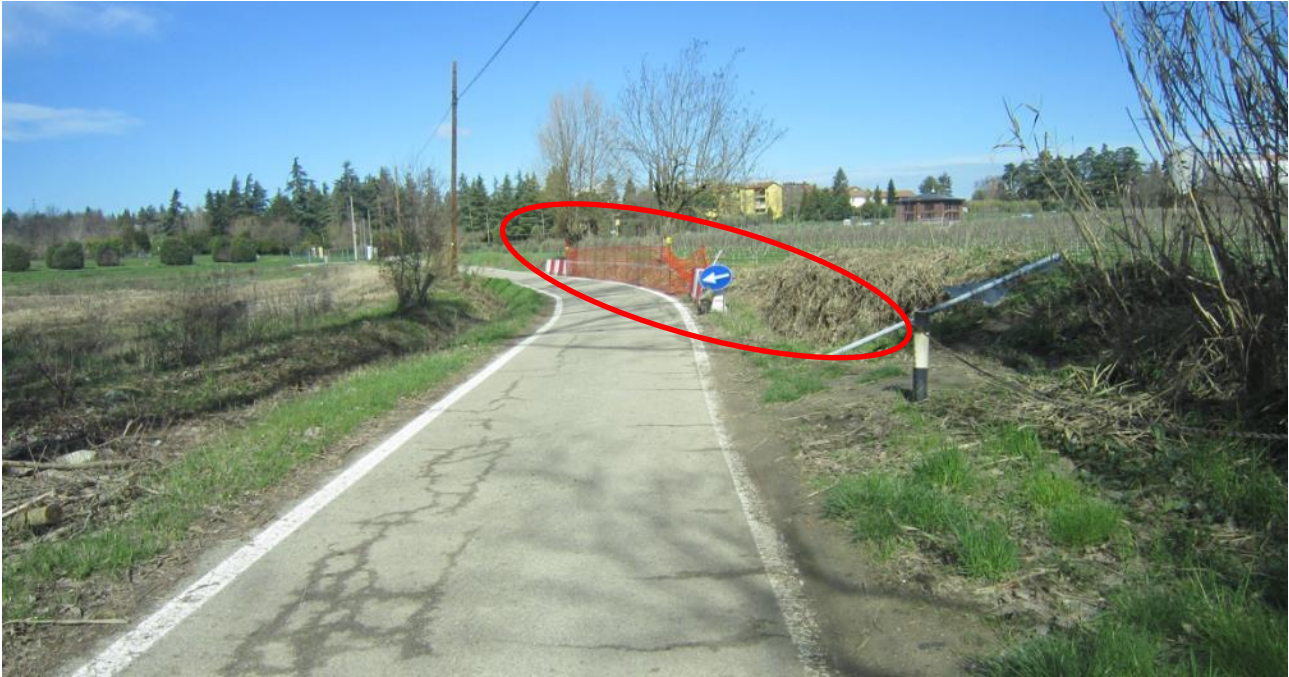
Foto con evidenziata la zona di intervento (tombamento)
